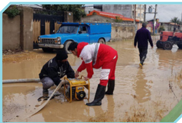
تخلیه آب از منازل و معابر
