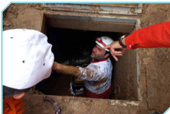
تلاش تیم‌های عملیاتی برای تخلیه آب - قم
